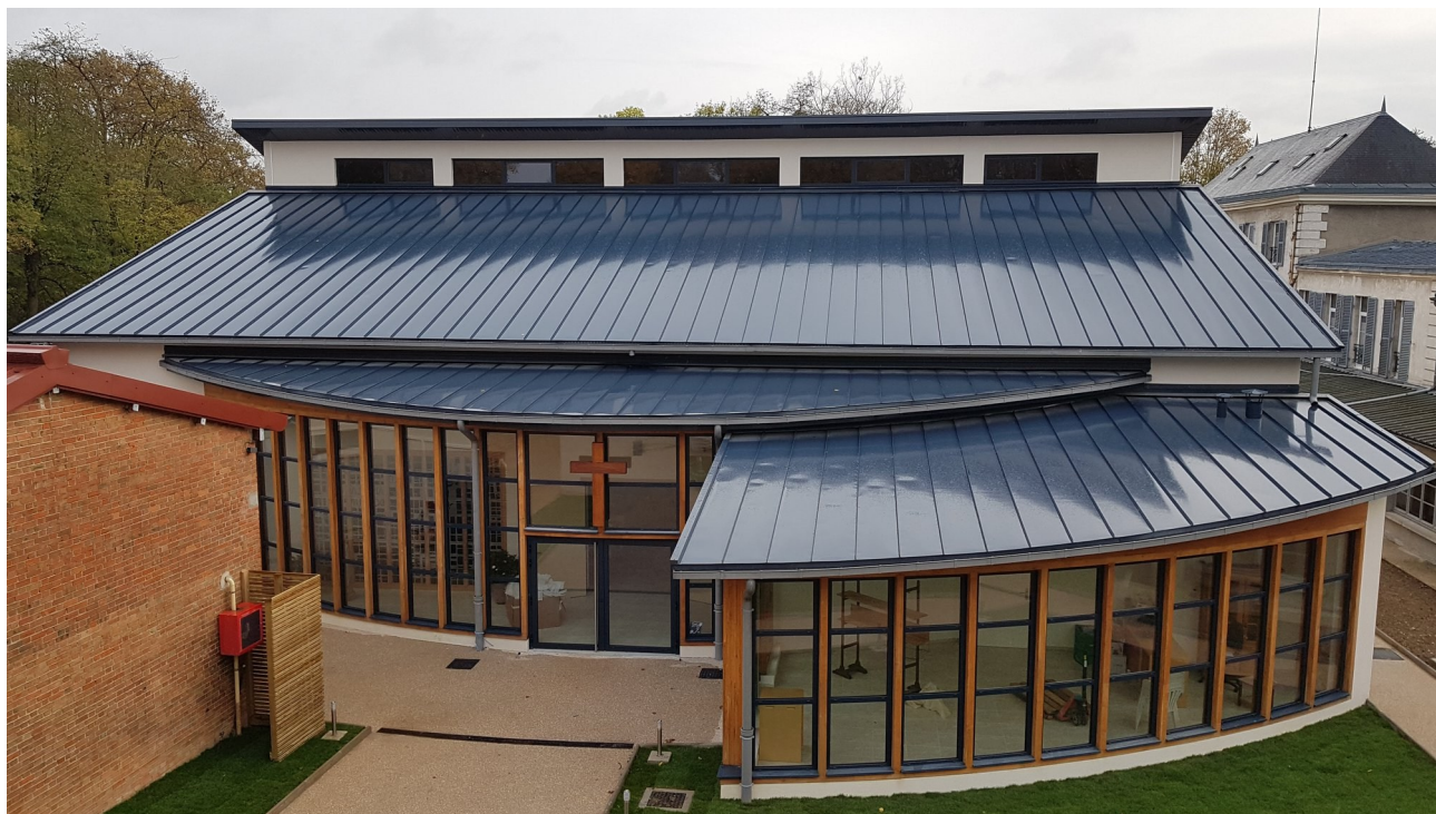
Monastère de l'Annonciade 38, rue Jean-François Marmontel 94320 THIAIS Profil Styl'innov® N°3 - 368 - 38 Coloris Ardoise RAL 5008 M.O. : Association Jeanne de France (94) Architecte : HEL ARCHITECTURE (76) Entreprise : REPISOL (91)
