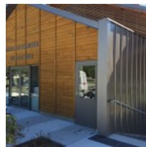
Immeubles de bureaux
